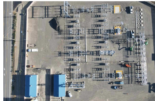
Vista aérea de la subestación de Railroad Avenue.
